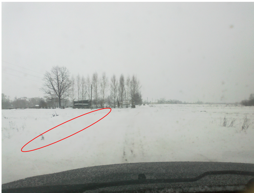
Attēls (pk 4+40) – ielas segums zaudējis šķērskritumu, ir vienā līmenī ar apkārtējā reljefa virsmu
